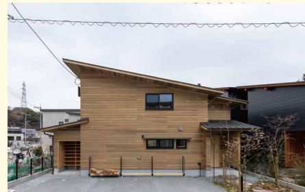
02 2025年完成 薪火のぬくもりと暮らす、土間のある住まい
